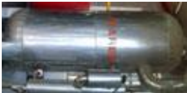
Hình 2.69: Bình trung gian nằm ngang
