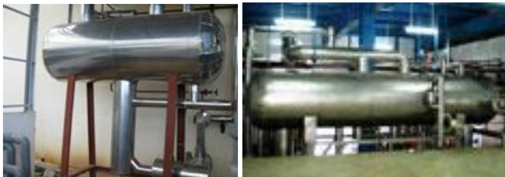
Hình 2.64: Bình chứa hạ áp
